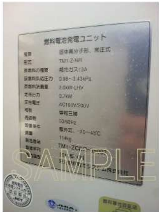
設置機器の銘板 (燃料電池ユニット)
